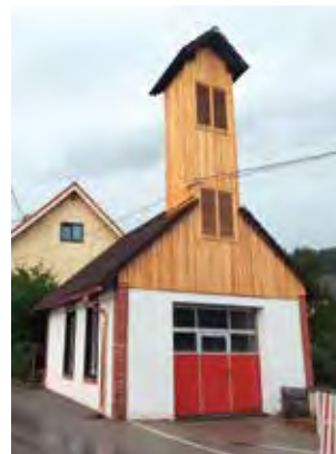
Zwischenstand beim Rüsthausumbau.
