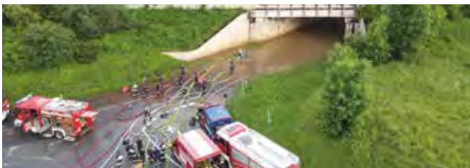
Unwettereinsatz bei der Bahnunterführung Richtung Stanz
