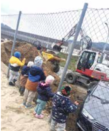
Fernwärme im Bereich des Freibades
