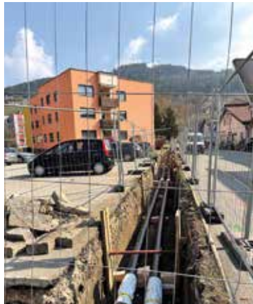
Fernwärme in der Teichgasse
