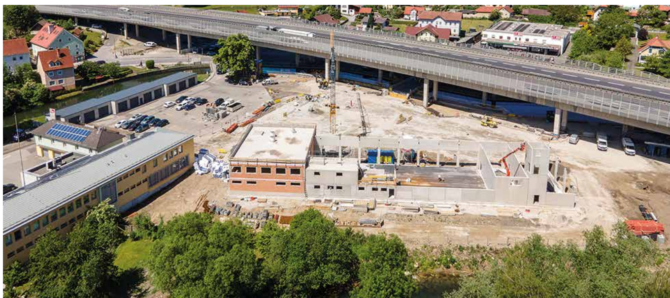
... und Ende Mai, kurz vor der Fertigstellung.
