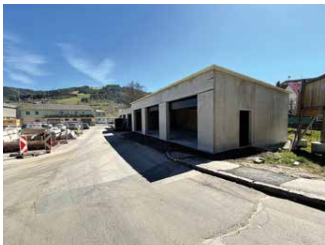
Der Neubau der E-Werk-Garagen Anfang April
