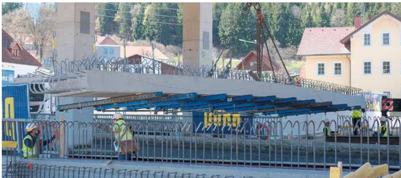
Einhebung der neuen Brücke am 8.4.2026
