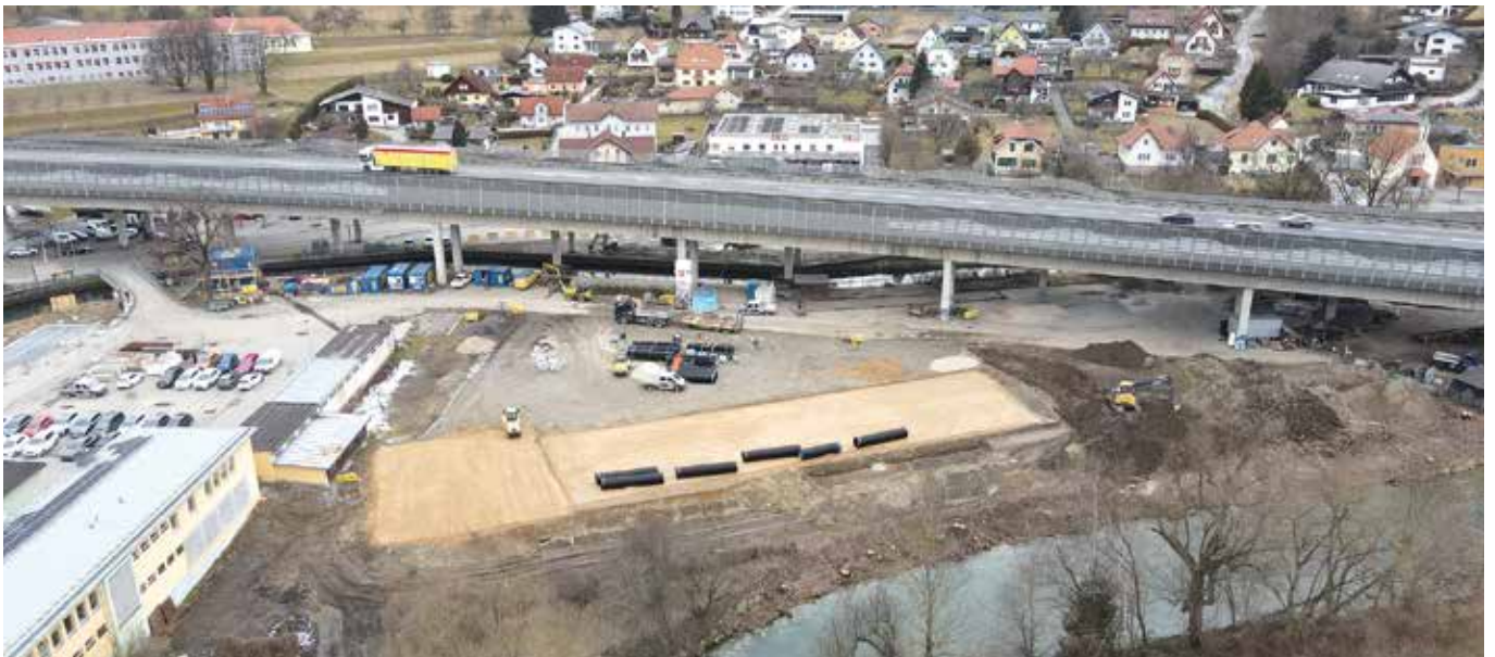
Großbauprojekt Roßdorfplatz - wie Mitte Februar alles begann...
