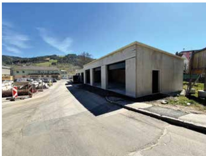
Der Neubau der E-Werk-Garagen Anfang April
