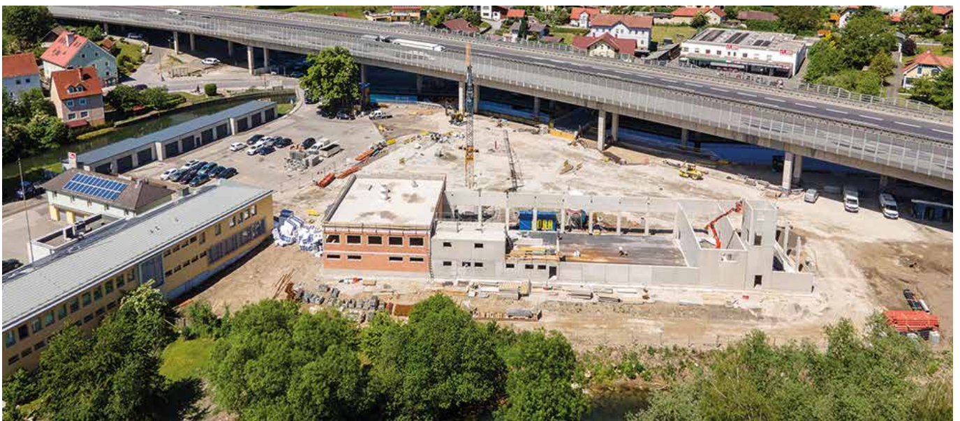
... und Ende Mai, kurz vor der Fertigstellung.
