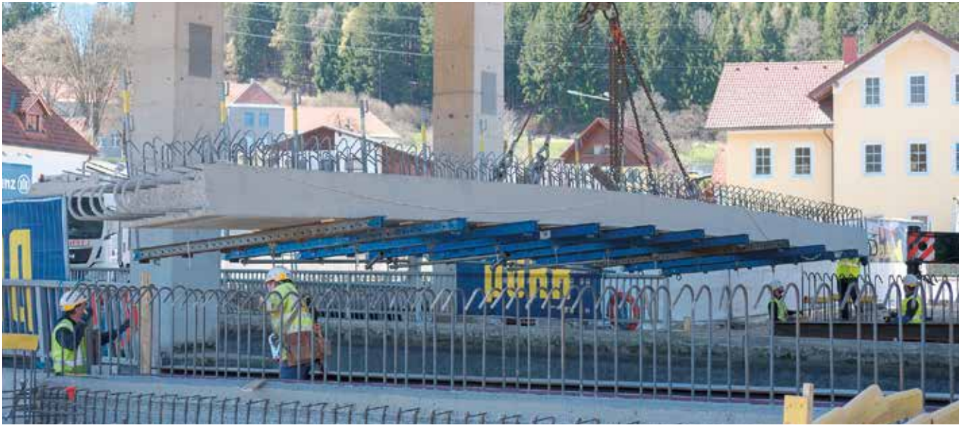
Einhebung der neuen Brücke am 8.4.2026
