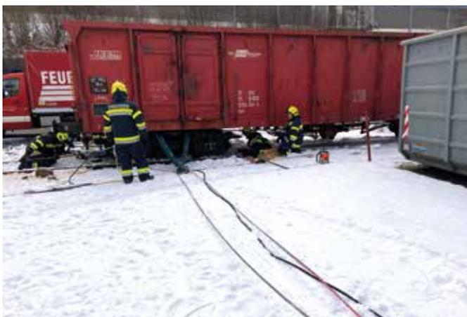
*Einheben eines entgleisten Schrottwaggons*
