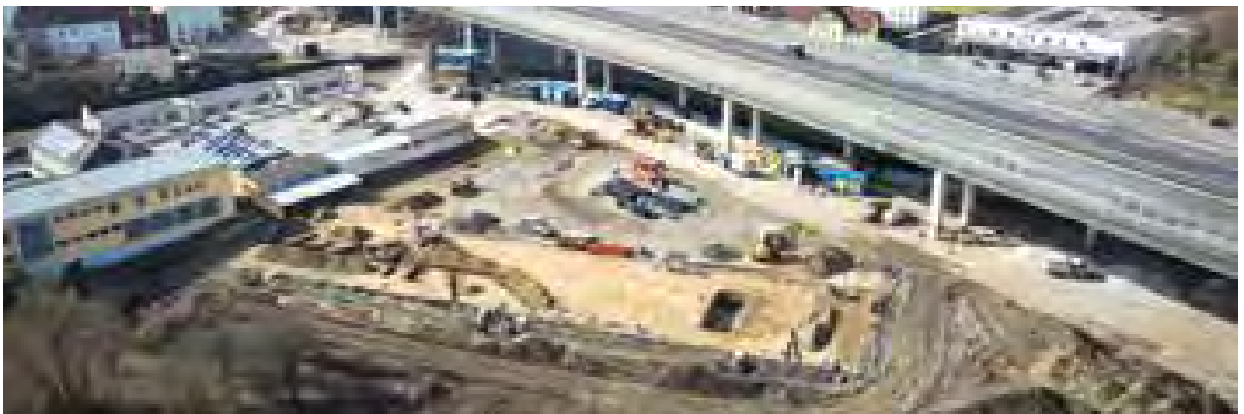
Das Großprojekt am Roßdorfplatz Ende Februar 2026
